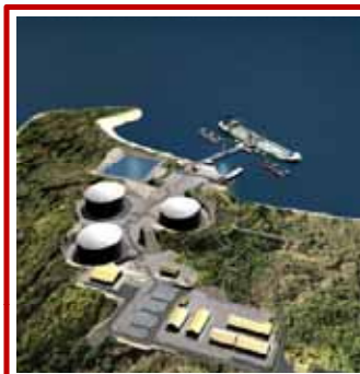
LNG Import terminal and storage
